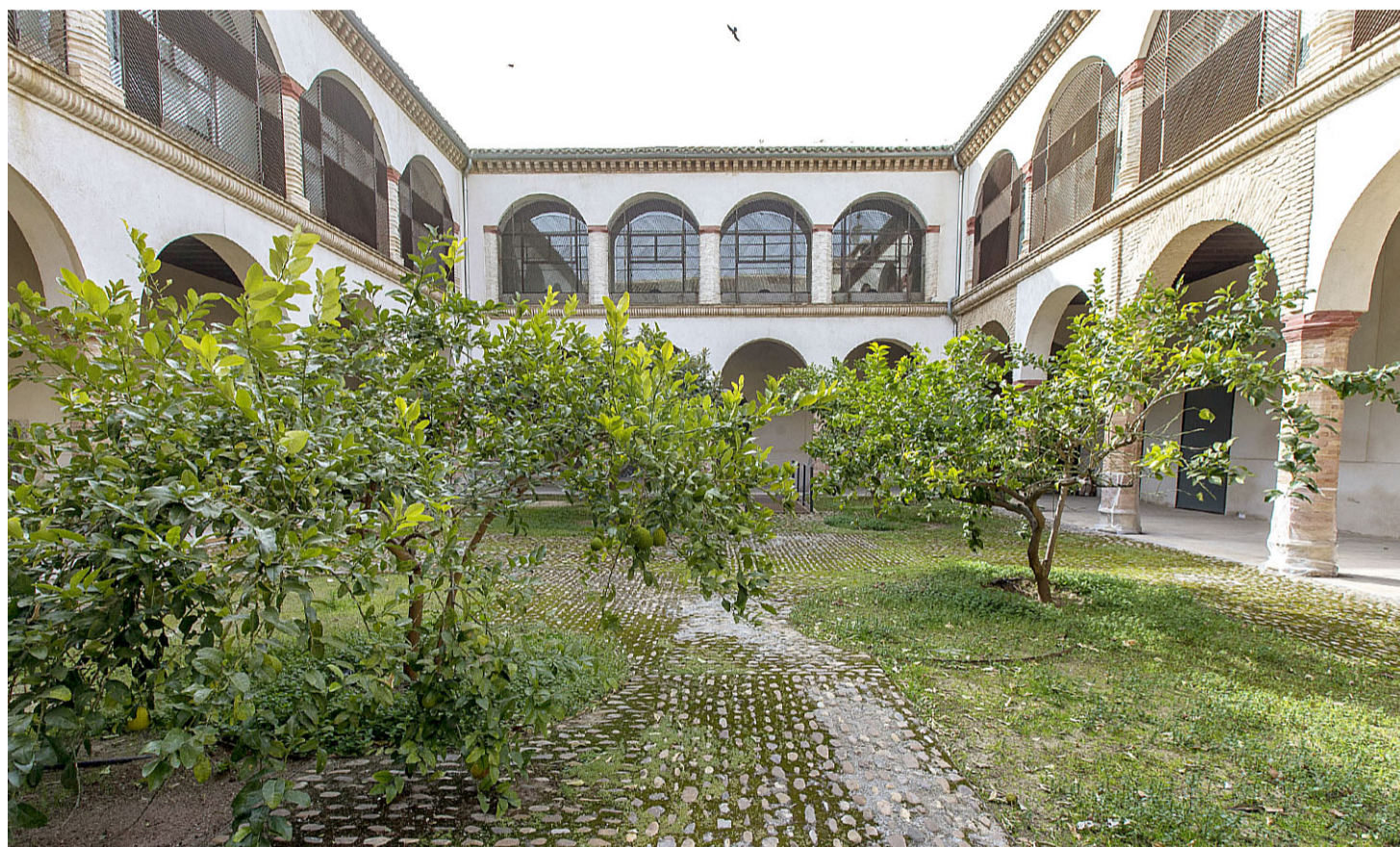
La obra se instalará de forma permanente en el patio de CORPO, en el antiguo claustro del convento de Santa Fe. / YOLANDA LANCHÁ
